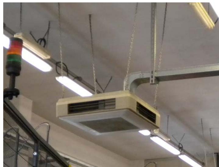
Unità interna del sistema a pompa di calore installata nel reparto elettroerosioni
